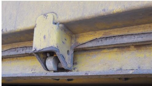
Abbildung III: Zeigt die Verriegelung im eingerasteten Zustand
